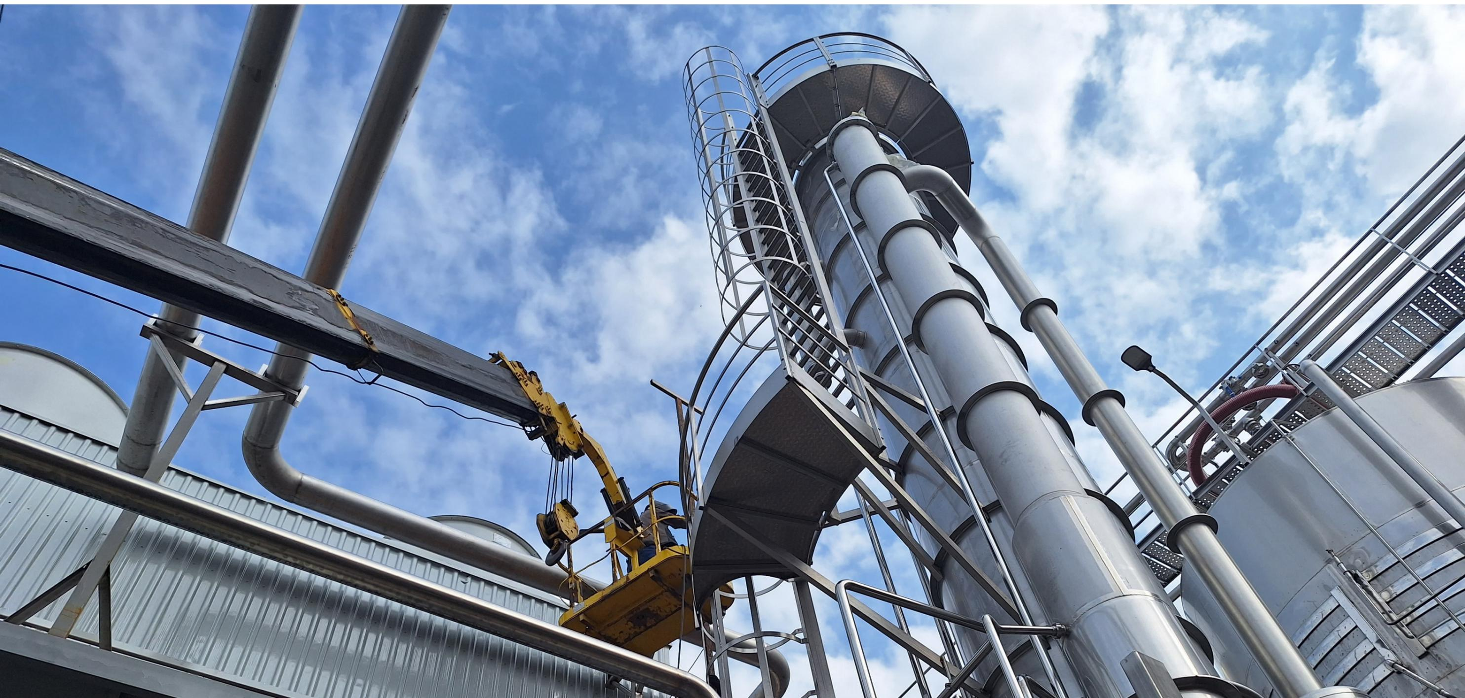
Queste semplici regole **sono la base del funzionamento di un concentratore** a multieffetto dove il mezzo riscaldante iniziale è vapore prodotto in forma esogena (caldaia) e con esso si porta alla temperatura di processo, in cui l'acqua contenuta riesce ad evaporare, il prodotto da concentrare.
