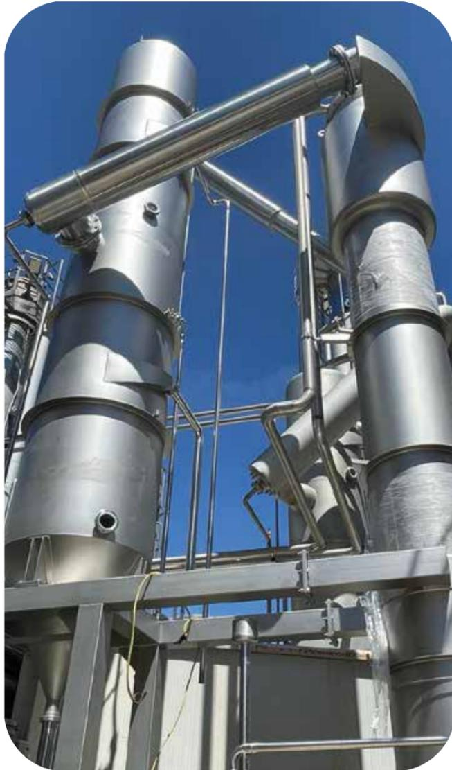
La ebullición genera una evaporación del agua libre presente y una consiguiente concentración del producto. Esta evaporación provoca una **“absorción de temperatura”** y, por tanto, el enfriamiento del propio producto.
